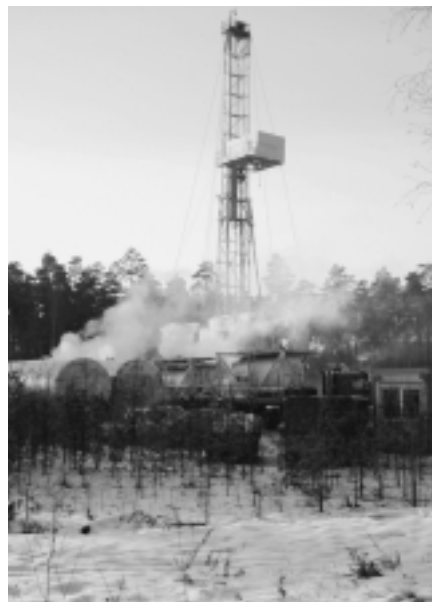
Abb. 2: Geothermie-Bohrung in Groß Schönebeck bei Berlin
